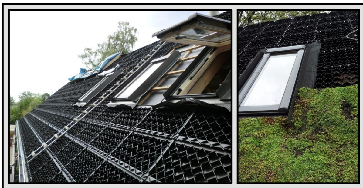
Abbildung 8: Rasterelemente / Wabenstrukturen zur Stabilisierung der Dachbegrünung auf Schrägdächern (Quelle Abb.: IPO, Quelle Bilder: https://www.dach-holzbau.de/artikel/gruendach-auf-dem-steildach-3161083.html )
